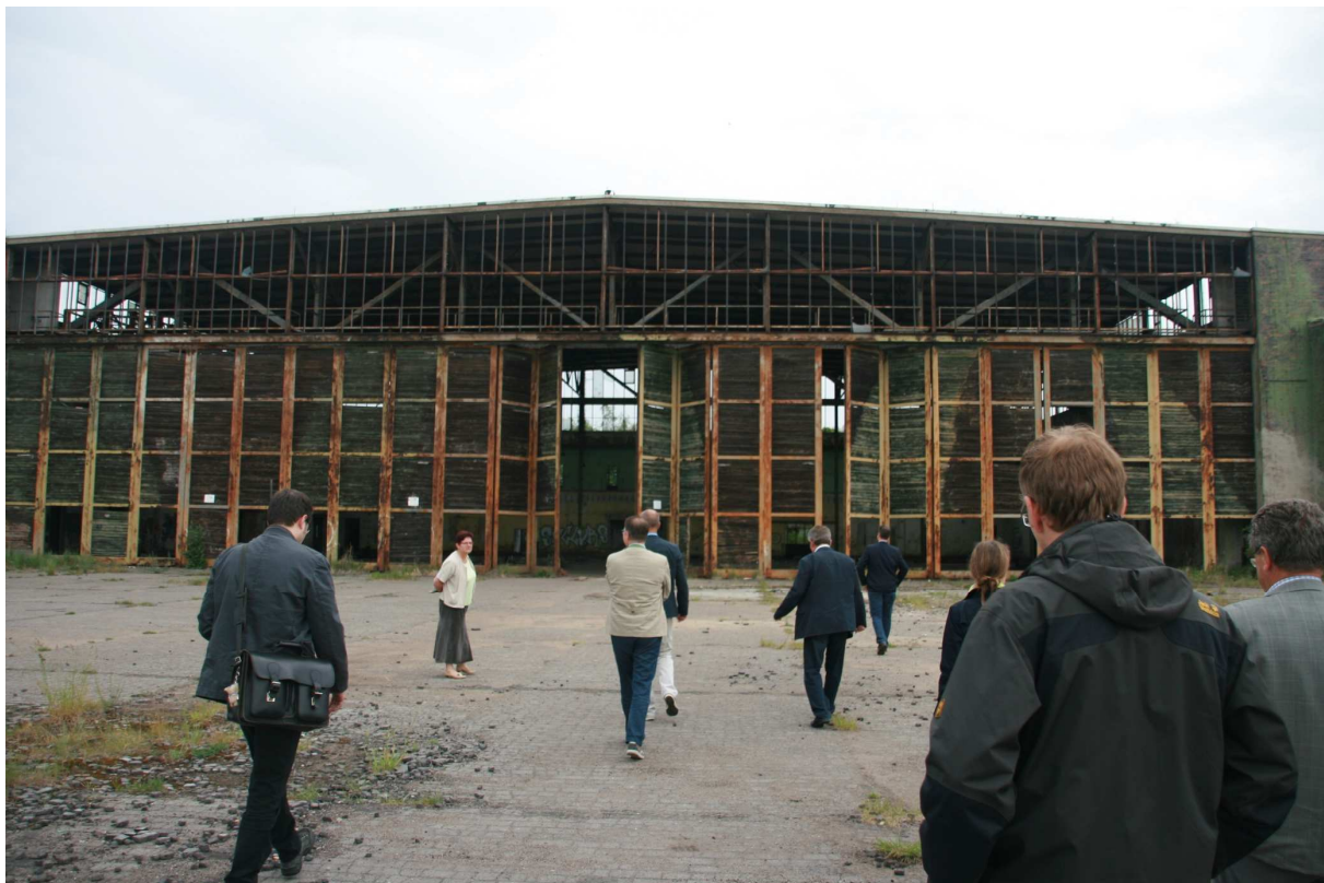
Die große Werfthalle in Falkenberg-Lönnewitz vor der Instandsetzung, Foto: Markus Hennen
