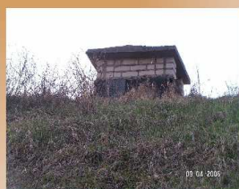
Entlüftung auf der Erdbabdeckung
