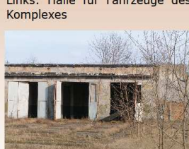
Teilansicht Halle Raketenfahrzeuge
