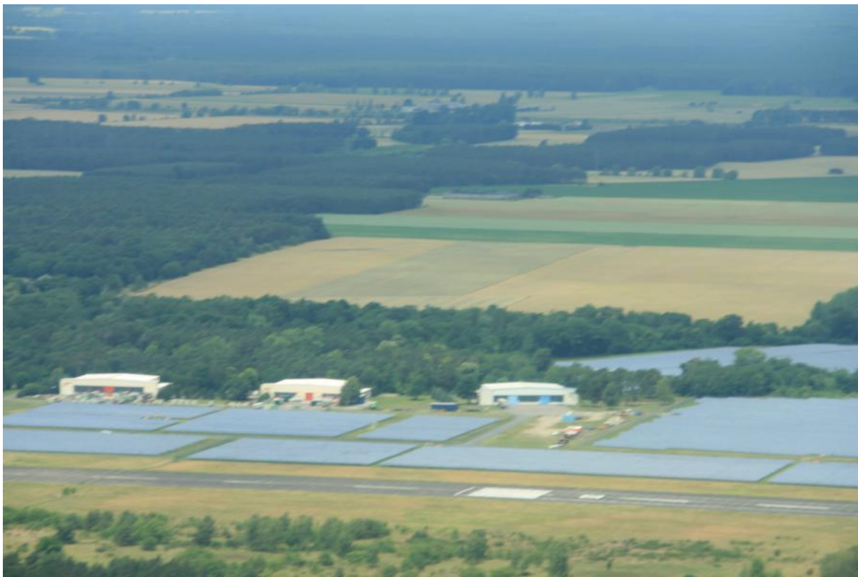
Blick auf die Start- und Landebahn, Hallen im Hintergrund links, Mitte UESA GmbH, rechts: Joh. Wacht GmbH
